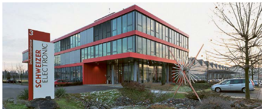
Firmengebäude der Schweizer Electronic AG in Reiden.
