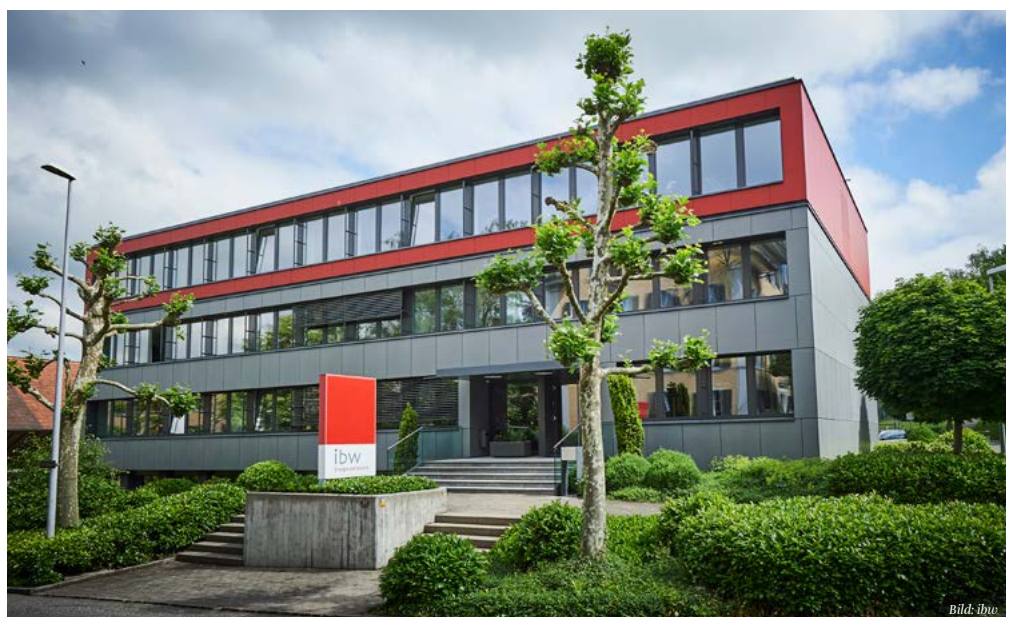
Das Betriebsgebäude von ibw.
