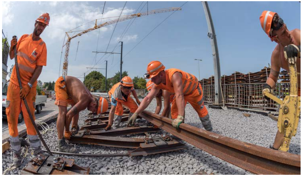
Präzision und Teamarbeit auf dem Bau, während im «Back Office» IQSoft die Rückverfolgbarkeit aller Massnahmen sicherstellt.
