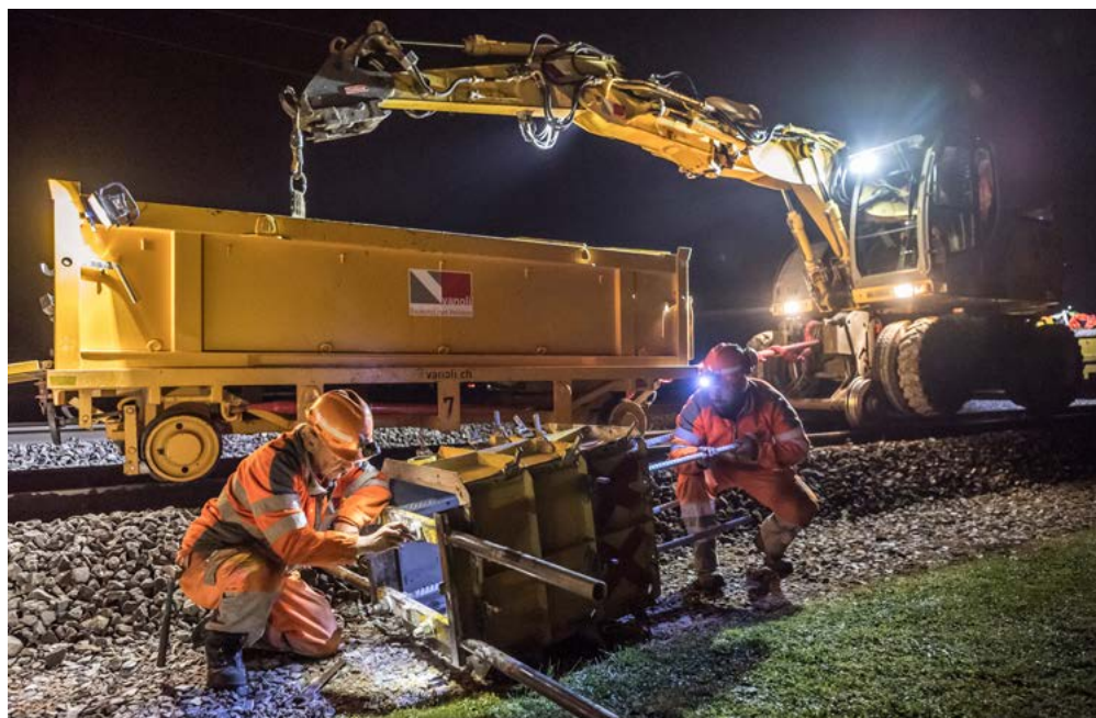
Gleisbauarbeiten im Freiamt: Die Vanoli AG ist ein wichtiger Dienstleister für die SBB.
